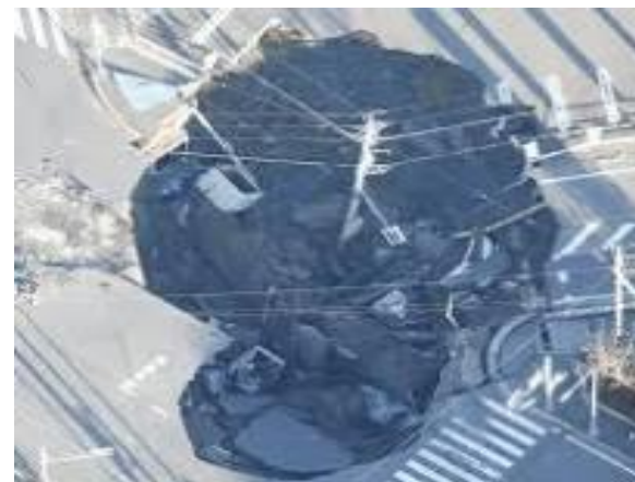
令和 7 年 1 月発生 埼玉県八潮市 下水道管破損
