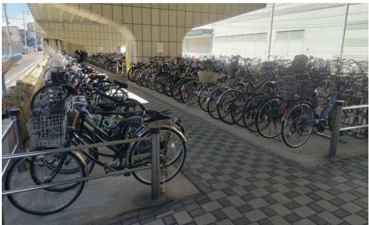
図 旭跨線橋下西自転車駐車場
