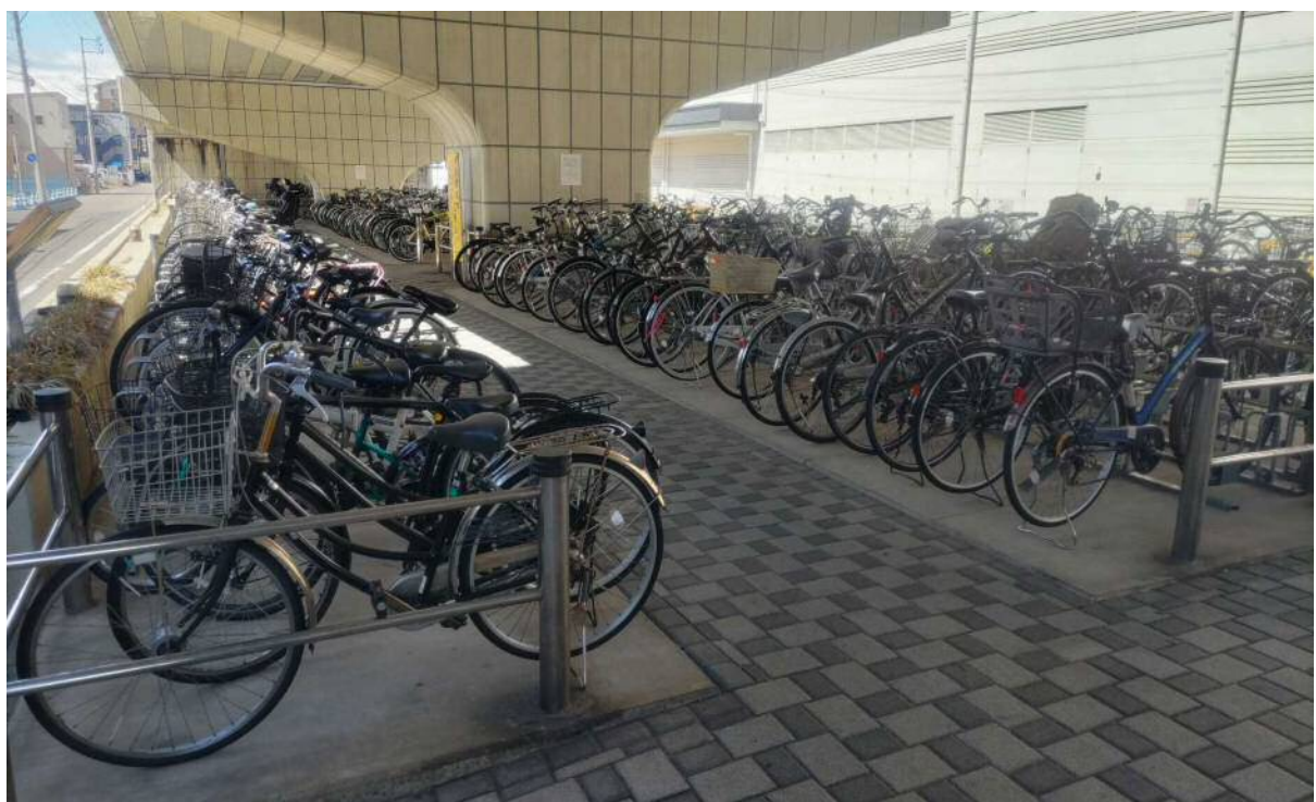
図 旭跨線橋下西自転車駐車場
