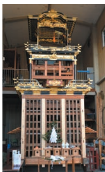
▲大上市場区山車 柱の取り換え修繕
