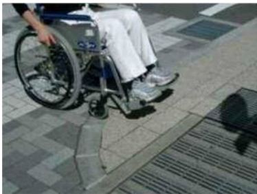
歩車道の段差改善
