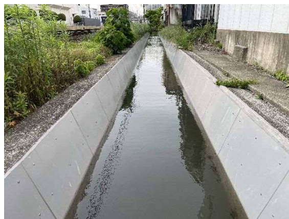
二之杵用排水路 完了
