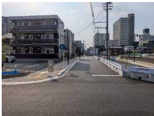
一部区間が供用開始した桜通線
