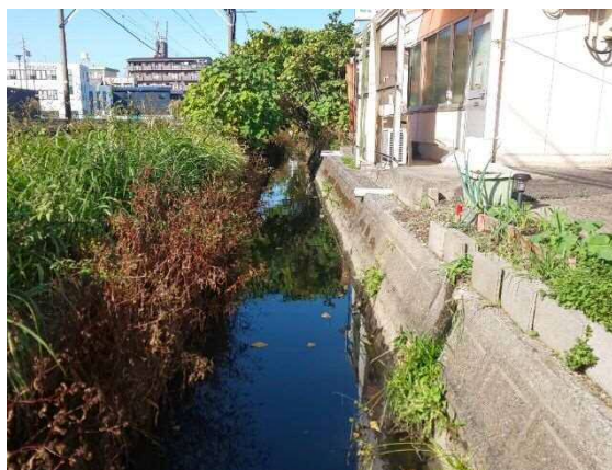
二之杵用排水路 着手前
