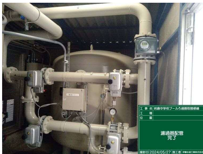
プールろ過機取替修繕（岩倉中学校）
