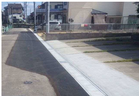
完了した側溝改良工事 (市道南 677 号線 川井町)
