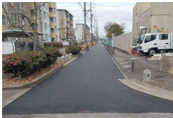
完了した舗装修繕工事 (市道南 57 号線 東新町)
