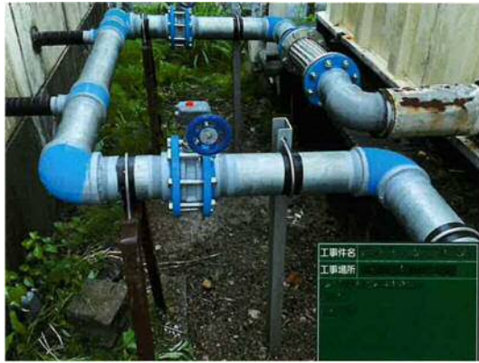
消火栓埋設管屋外漏水修繕(曾野小学校)
