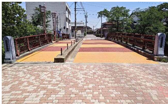
大市場橋上部全景
