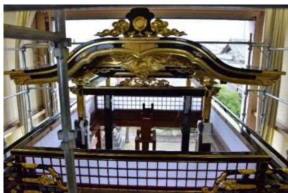
下本町区の山車修繕（全体の金箔や漆塗り）
