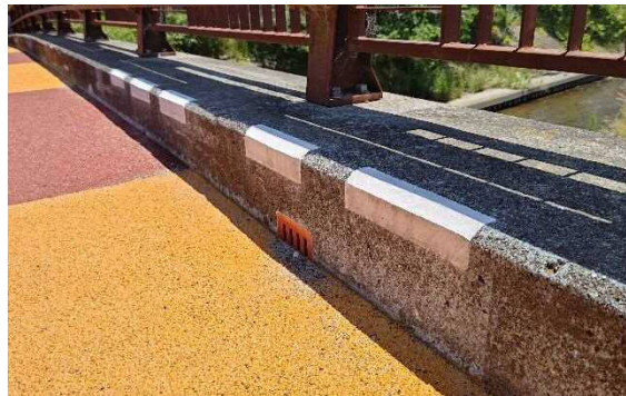
修復をした大市場橋の地覆
