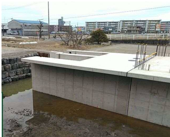
下部工工事を行った大市場排水機場
