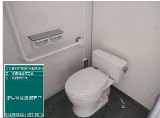
トイレの洋式化（南部中学校）
