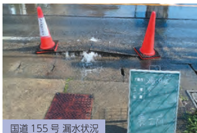
国道155号 漏水状況
