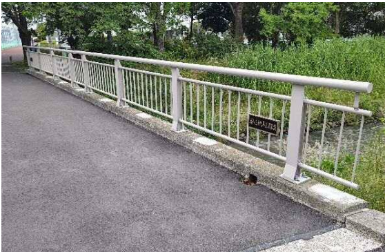
設置した防護柵
