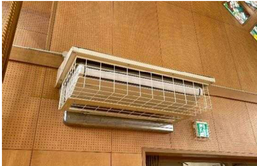
屋内運動場に設置した空調設備（岩倉東小学校）
