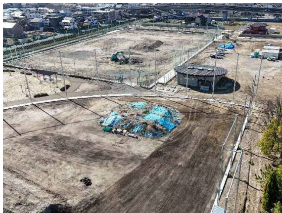
石仏公園整備工事 (令和8年3月末時点)
