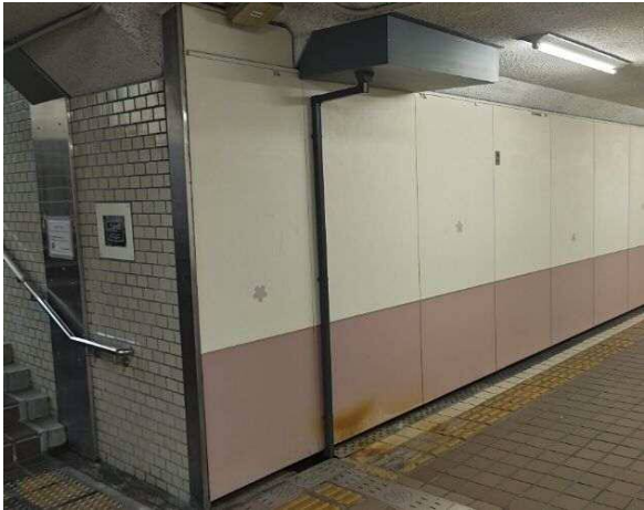
地下連絡通路の雨漏り箇所に設置した樋
