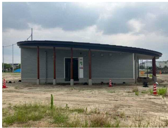
石仏公園管理棟新築工事完成
