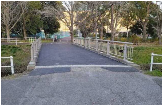
改修工事後の新矢戸橋上部全景
