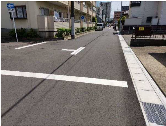
完了した側溝改良工事 (市道南 174 号線 栄町)
