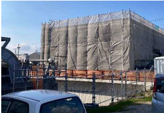
上屋工（躯体）工事を行った大市場排水機場
