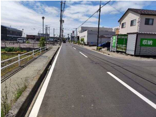
完了した舗装修繕工事 (市道団地西線 大市場町)
