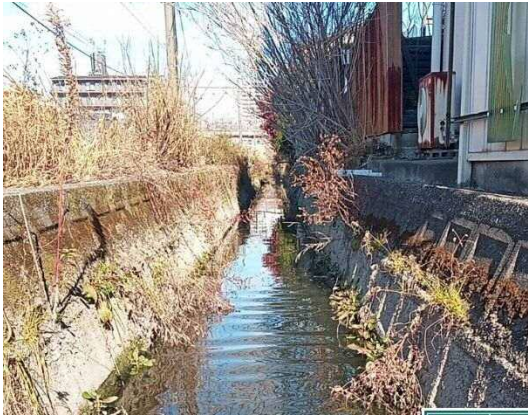
二之杵用排水路 着手前
