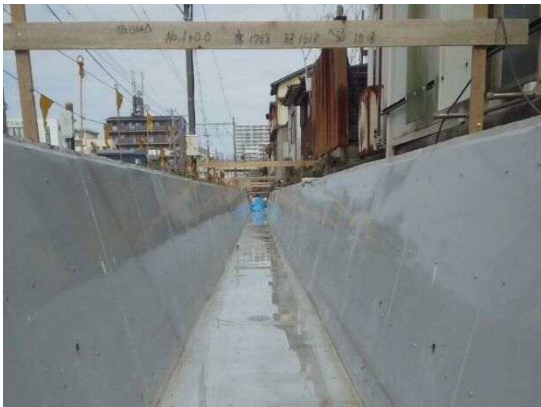
二之杵用排水路 完了
