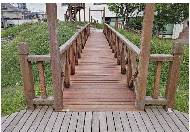
修繕後の辻田公園木製複合遊具
