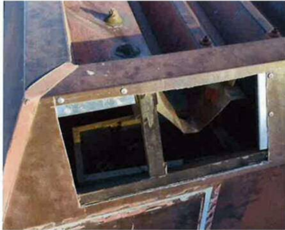
駅西階段屋根に設置した点検口
