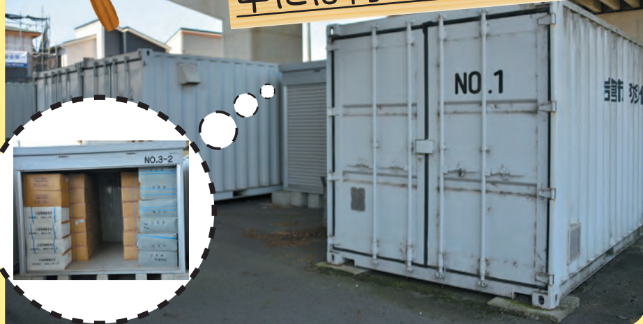
▲中野防災倉庫
