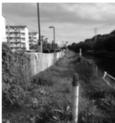
新矢戸橋から見た右岸堤防
