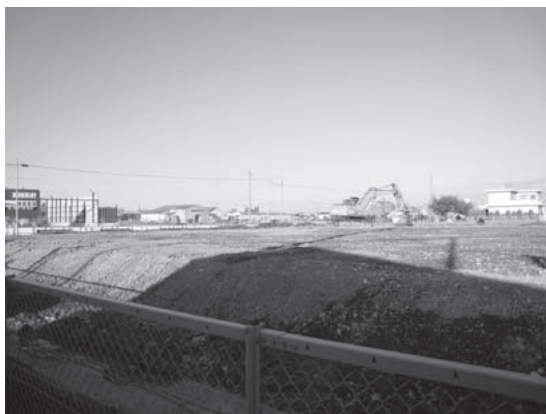
新学校給食センターの工事風景
