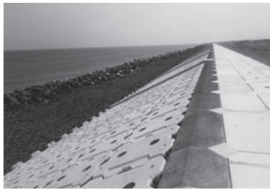
復旧の完了した岩沼市の防潮堤
