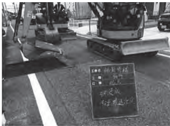
舗装工事の様子
