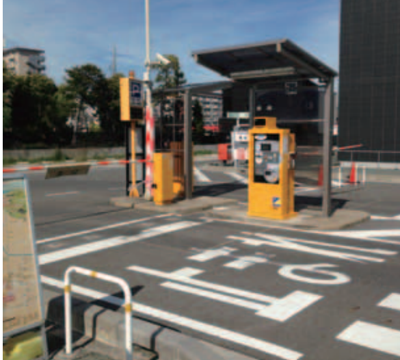
犬山市役所の駐車場ゲート
