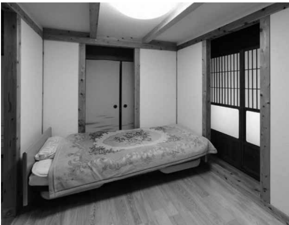
6畳の和室内に「耐震シェルター」を 設置した事例
