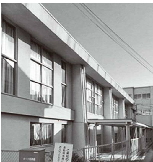
岩倉南小学校体育館の窓ガラス
