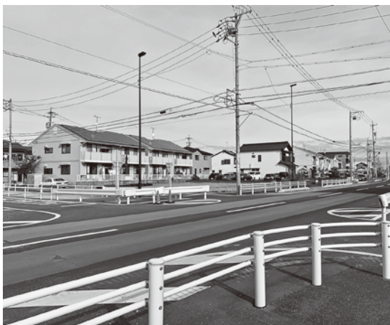
夢結橋西の交差点:信号設置および用水路沿い2本の道路の1本化を求む
