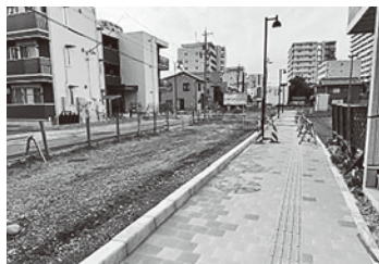
地中化で進む桜通線街路事業
