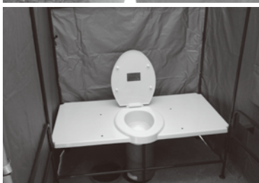
下水道直結型マンホールトイレ
