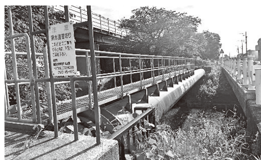
県水上水道水管橋
